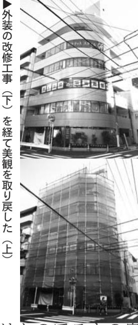
▲外装の改修工事(下)を経て美観を取り戻した(上)
