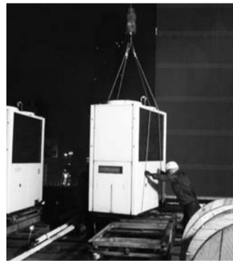
▲夜間での作業風景
